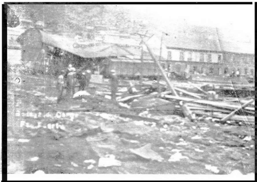
N 82. Coquimbo.—Bolega de carga de la estación del ferrocarril.
