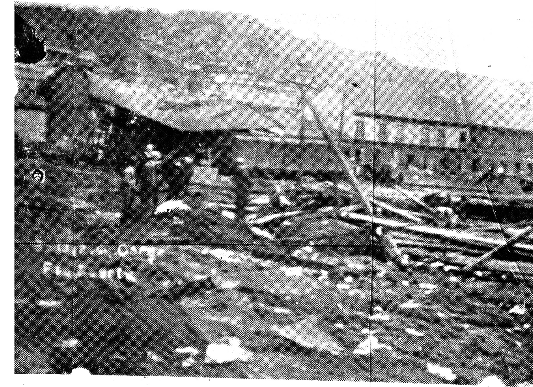
N.º 82. Coquimbo.—Bodega de carga de la estación del ferrocarril.
