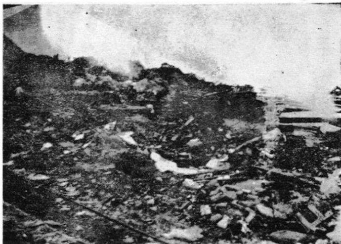
N.º 53. Chañaral.—Destrozos del maremoto.
