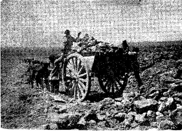
Fig. 28.—Carguío de caliche en carreta.
