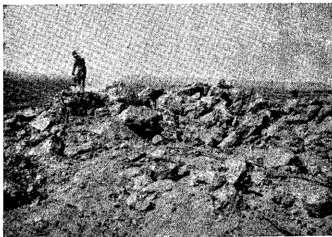
Fig. 12.—Taladrando cachorros para romper bloques de caliche.
