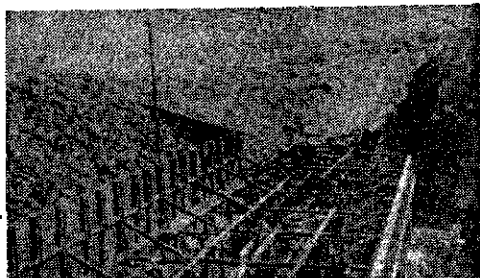
Fig. 34.—Rampa de los chanchos.
