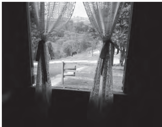
FOTO 3: DETALHE DA JANELA (CASA APROPRIADA).
